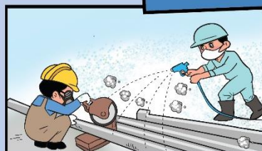
ลดการฟุ้งกระจายฝุ่น เช่น การใช้สเปรย์น้ำ หรือ พรมน้ำลงวัตถุที่ตัดแต่ง ให้ชุ่มก่อนขณะตัด
